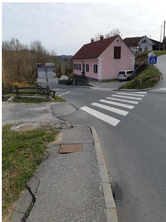
Fotografija 2: Prehod za pešce pri šoli
